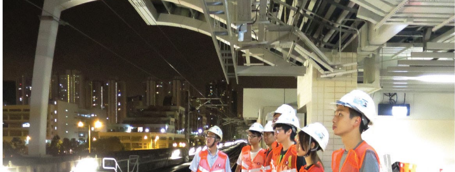
暑期实习生们在导师带领下到港铁马鞍山线改善工程项目的其中三个地盘进行工地考察。
