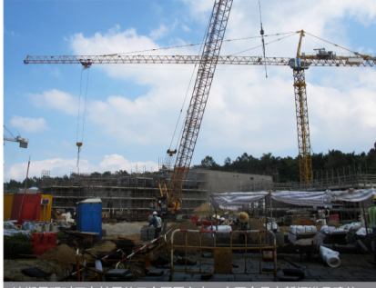
迪斯尼现时正在扩展的三个园区之中，有两个是由新福港承建的
