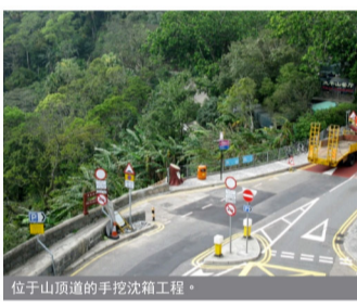
位于山顶道的手挖沈箱工程。
